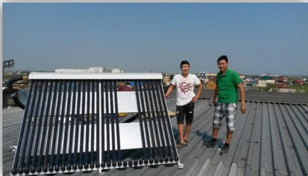
Монтаж систем солнечной генерации
